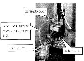
(a) ストレーナーの中にある赤い浮き球が浮い ていたら水分が混入しています、カップを外 しストレーナー内の水分を除去し、フィルタ ーを掃除してくだざい。
