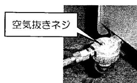
(イ) バーナーの送風スイッチを『ON』にした次に燃焼スイッチを『ON』にして燃料ポンプを起動させ、燃料ポンプの上についている空気抜きバルブを開きノズルから燃料が出るまで空気を抜きその後バルブを閉じ、燃焼スイッチと送風スイッチを『OFF』にしてください。
